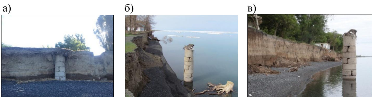
Рисунок Б.5 – Переработка абразионно-аккумулятивных берегов с образованием пляжа и клифа
