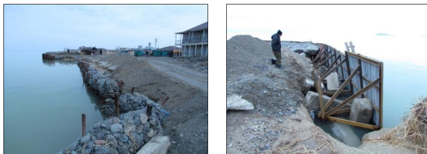
Рисунок В.6 – Проводимые берегоукрепительные работы с использованием габионов и железобетонных конструкций на побережье оз. Алаколь (с. Кабанбай) собственниками зон отдыха
