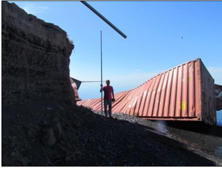
Рисунок В.17 – Разрушенное под ветро-волновым воздействием берегоукрепительные сооружения у базы отдыха «Керемет», берег рекреационной зоны Акши
