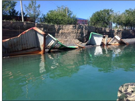
Рисунок В.17 – Разрушенное под ветро-волновым воздействием берегоукрепительные сооружения у базы отдыха «Керемет», берег рекреационной зоны Акши
