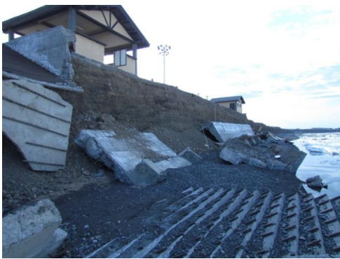
Рисунок В.17 – Разрушенное под ветро-волновым воздействием железобетонное берегоукрепление базы отдыха «Гранд Виле», берег рекреационной зоны Акши.
