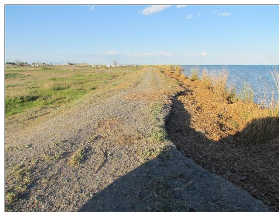
Рисунок А.54 – Грунтовая дамба для защиты от подтопления и размыва восточной части с. Камыскала
