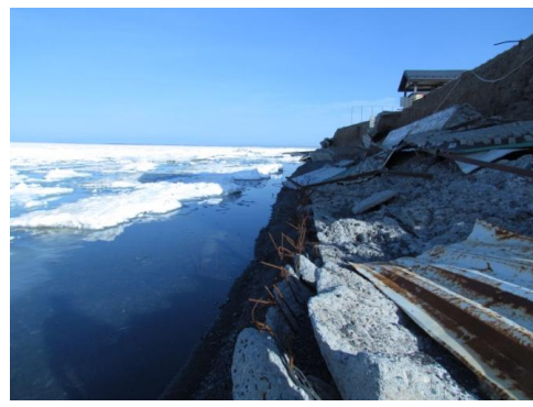
Рисунок В.17 – Разрушенное под ветро-волновым воздействием железобетонное берегоукрепление базы отдыха «Гранд Виле», берег рекреационной зоны Акши.
