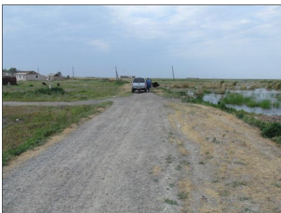
Рисунок А.54 – Грунтовая дамба для защиты от подтопления и размыва восточной части с. Камыскала
